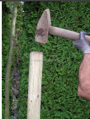
12. Schritt: Höhenkorrektur mit dem Hammer.
